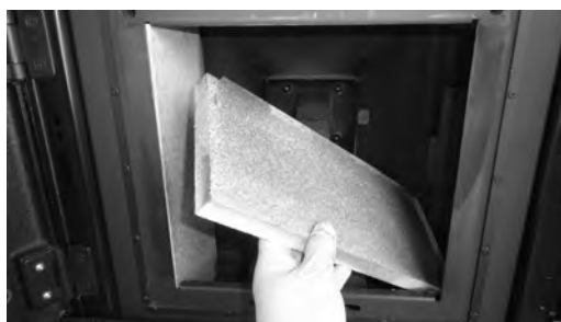
耐火レンガ（側面）の抜き取り
