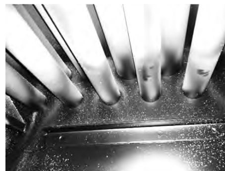
熱交換パイプの清掃
